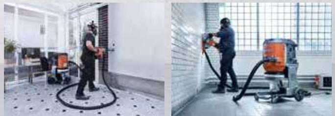
Bei trockenen Trenn-/Bohrverfahren wird der Staub direkt am Entstehungsort mithilfe einer H-klassifizierten, mit HEPA H13-Filtern ausgestatteten Staubabsaugvorrichtung gesammelt, deren Luftdurchsatz und Kapazität an die jeweilige Applikation angepasst ist. Die Umgebungsluft wird mithilfe eines oder mehrerer tragbarer Luftreinigungsgeräte mit HEPA H13-Filtern mindestens 6- bis 10-mal pro Stunde gereinigt.
