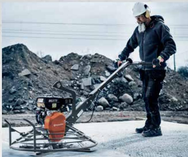
**STAHLABZIEHFLÜGEL** Abziehflügel werden zum Abziehen der Betonoberfläche in der Anfangsphase des Betonendbearbeitungsprozesses verwendet. Husqvarna Abziehflügel haben eine nahezu flache Oberfläche, wodurch der Sog zwischen Flügel und Oberfläche entsteht. Dadurch wird der Beton von einer höheren zu einer niedrigeren Position auf der Platte bewegt.
