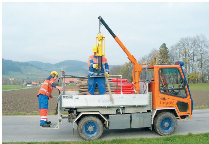
Pfahltreiber im Einsatz bei einer Gemeinde.
