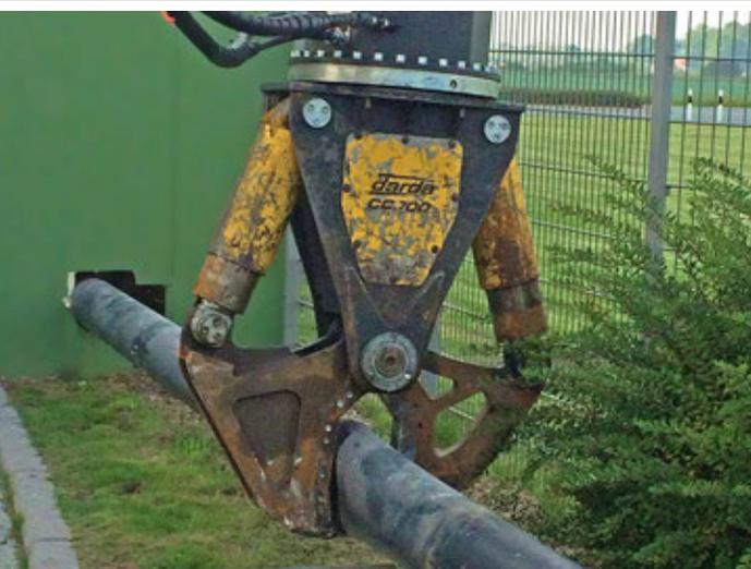
Explosionsgefahr auf einem in der Erde liegenden Kavernenspeicher – wie also das oberirdische Rohrleitungssystem sicher und trotzdem schnell zurückbauen? Die Darda Stahlschere CC700 S, macht solche Einsätze möglich.
