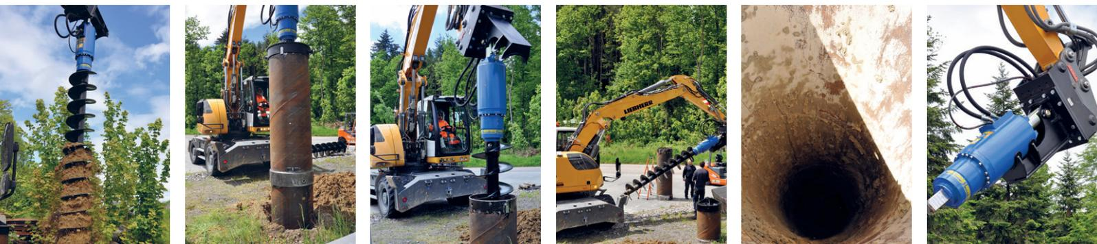
Verrohrte Bohrsysteme von Terrasystems werden kundenspezifisch gefertigt. Sie wählen den gewünschten Bohrdurchmesser und die benötigte Tiefe. Die Tiefe kann modular mit 2- oder 3-Meter-Stücken erreicht werden. Wollen Sie die Effizienz noch steigern? Bereiten Sie mehrere Rohre gemeinsam vor und füllen Sie alle gleichzeitig.
