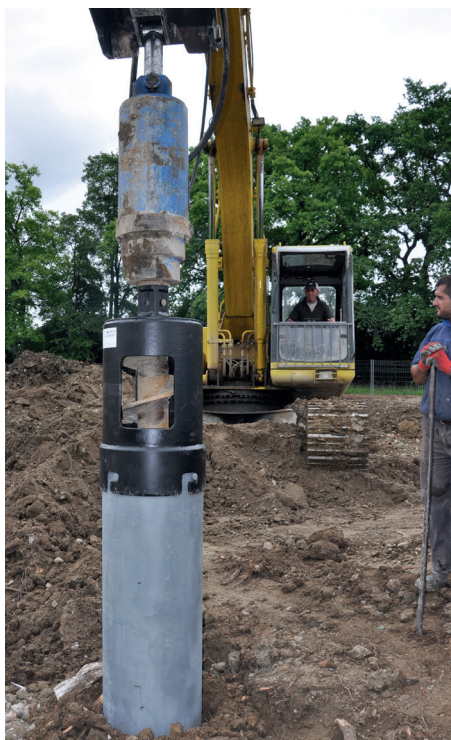
Verrohrt bohren für Rühlwände.
