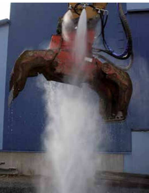
Hochdruck-Staubunterdrückungssystem HPW-Dust im Einsatz.
