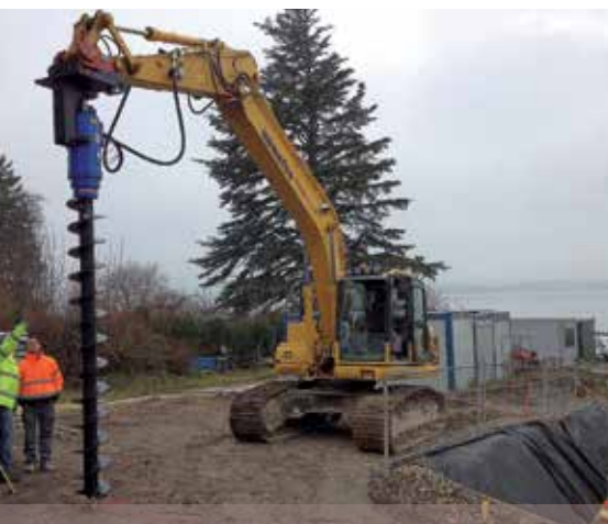
Auch grosse Antriebe mit langen Bohrschnecken und Verlängerung sind möglich.
